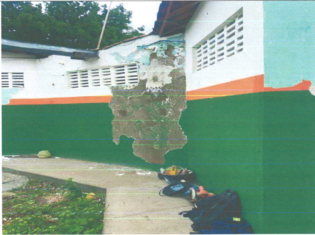
Demolição do reboco
