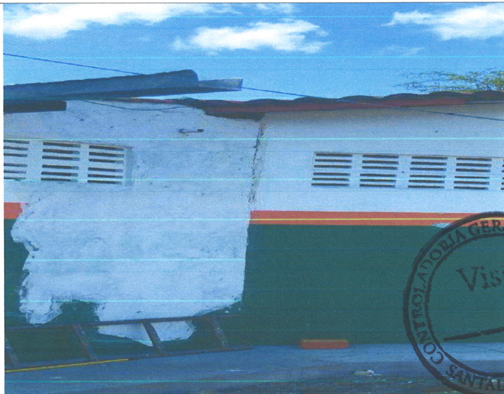
Execução de reboco
